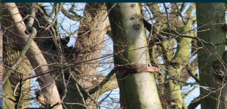
Im oberen Kronenbereich wurde eine Dreipunktsicherung mit Gurtband installiert.
