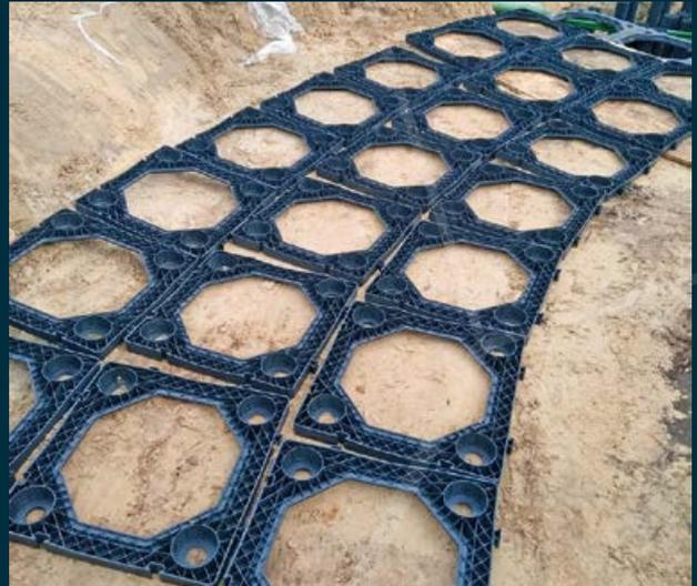
2. Die Rahmen (frames) werden gemäß Layoutzeichnung platziert. Die Einheiten können mit maximal 75 mm Abstand installiert werden, wodurch auch Kurven und abweichende Formate möglich werden. Gesamtgröße max. 675 x 675 mm.
