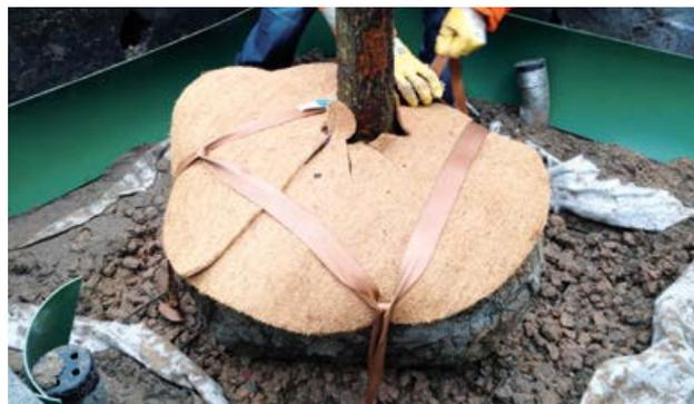
Für zusätzlichen Halt wird der Landschaftsgärtner den Ballen mit Gefa Treelock verankern. Dabei werden drei der Baumgröße entsprechend dimensionierte Gurtbänder per Erdanker fixiert und mit einem Spanngurt verzurrt. Der Baum ist nun bestens vorbereitet und kann seine vielfältigen Aufgaben im komplexen urbanen Umfeld wahrnehmen.
