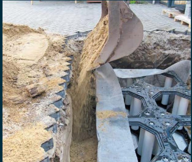
6. Das System wird nicht vollständig gefüllt; eine variable Luftschicht ist notwendig, um Schäden durch Wurzelwachstum zu vermeiden. Die Luftschicht wird mit einem Belüftungs-/Bewässerungssystem versehen, das für die Zuleitung von Sauerstoff und Wasser notwendig ist.
