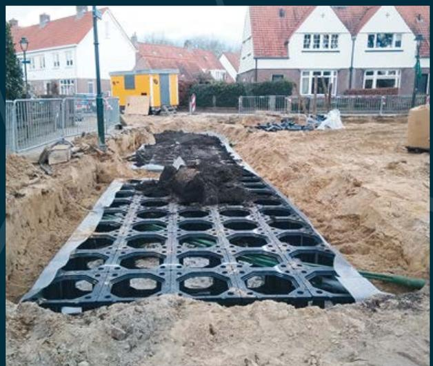
4. Nach Installation aller Einheiten und Integration der Kabel und Leitungen wird das System von einer Trennschicht umschlossen. Diese Trennschicht kann sowohl wasserdurchlässig als auch wurzeldicht ausgeführt werden (z.B. mit Geotextilvlies).
