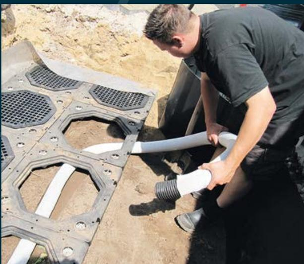
7. Nachdem alles installiert ist, kann das System verschlossen werden. Das System eignet sich auch für den Einsatz unter wasserdurchlässiger Fahrbahndecke, denn das Regenwasser infiltriert durch die Abdeckungen (decks) bis in das Baumsubstrat.
