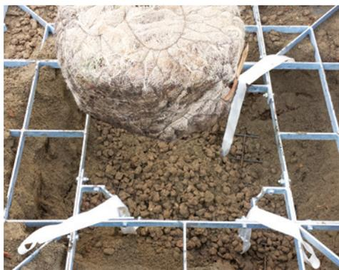
Der Grund dafür ist die Reizgebung durch Bewegungen an den Wurzeln, die bei dieser Verankerungsvariante intensiver ist. Gehen wir von einem „Worst Case“ aus und nehmen den Zeitraum von mindestens 3 Jahren an, so sollte eine biologisch abbaubare Unterflurverankerung nachweislich einen Zeitraum von min. 3 Jahren im Erdboden überdauern, ohne seine Funktion zu verlieren, um somit den geraden Wuchs des Baumes zu gewährleisten.
