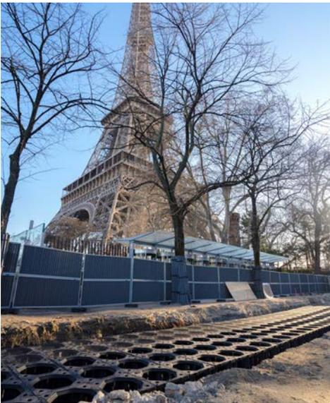
Das unterirdische Gerüst aus beliebig vielen Einzelkammern schafft einen großen durchwurzelbaren Raum für optimales Wachstum. Dank versetztem Verbund lassen sich Schrägen oder auch runde Pflanzgruben sowie Kurvenverläufe bis zu einem Radius von fünf Meter problemlos realisieren. Um
