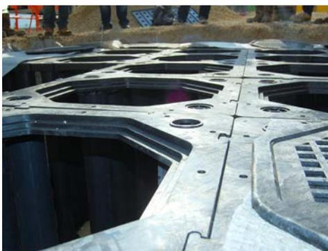
Das Kopfteil der Wurzelkammermodule wird auf die Pfosten gesteckt und dann mit dem Bodenteil verbunden. Das eigentliche Pflanzloch für den jeweiligen Baum bleibt dabei ausgespart. Durch die oberen Öffnungen kann nun das Substrat eingefüllt werden. Abschließend wird das Modul mit einem Deckel versehen. Jetzt werden die Module mit einem Vlies bedeckt und der gewöhnliche Schichtüberbau (Trag- und Ausgleichsschicht, sowie Pflaster oder Asphalt) kann erfolgen.
