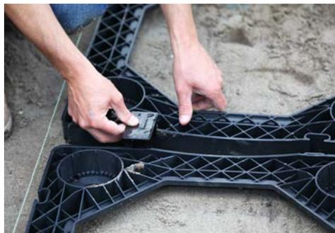
Die neuen -Spacer- sind in 50 mm und 75 mm erhältlich und werden einfach zwischen die Rahmen eingesetzt. Das Verbinden der Rahmen erhöht die Stabilität des gesamten Systems und gewährleistet, dass sich die einzelnen Elemente während der Installation nicht verschieben.
