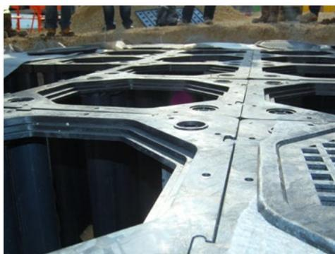
Das Kopfteil der Wurzelkammermodule wird auf die Pfosten gesteckt und dann mit dem Bodenteil verbunden. Das eigentliche Pflanzloch für den jeweiligen Baum bleibt dabei ausgespart. Durch die oberen Öffnungen kann nun das Substrat eingefüllt werden. Abschließend wird das Modul mit einem Deckel versehen. Jetzt werden die Module mit einem Vlies bedeckt und der gewöhnliche Schichtüberbau (Trag- und Ausgleichsschicht, sowie Pflaster oder Asphalt) kann erfolgen.
