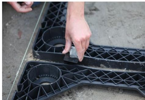
Die -Spacer- sind in 50 mm und 75 mm erhältlich und werden einfach zwischen die Rahmen eingesetzt. Das Verbinden der Rahmen erhöht die Stabilität des gesamten Systems und gewährleistet, dass sich die einzelnen Elemente während der Installation nicht verschieben.
