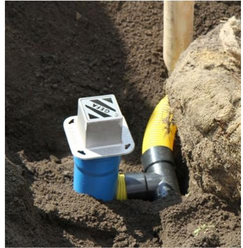
Ein Filter verhindert, dass Laub oder Müll die Leitung verstopfen. Über einen T-Adapter legt man einen Bewässerungsring um den Ballen. Der Bewässerungsanschluss ist kompatibel mit allen Adaptern DN 80. „Für Neupflanzung von Bäumen im urbanen Raum ist Luwa die beste Option“, versichert Carstens.
