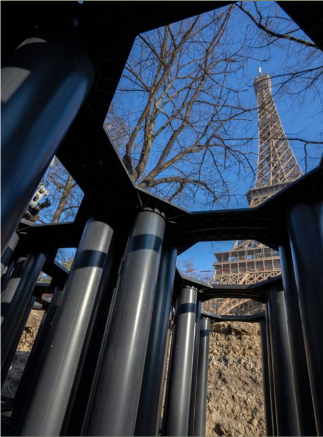
Bauvorhaben Paris, Eiffelturm
