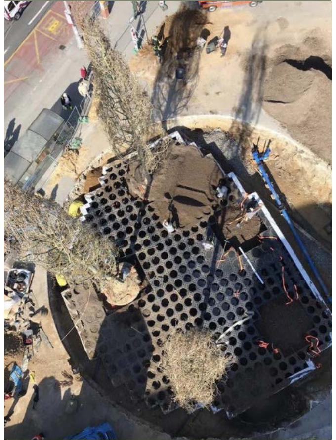
Bauvorhaben Bratislava, Stadtzentrum
