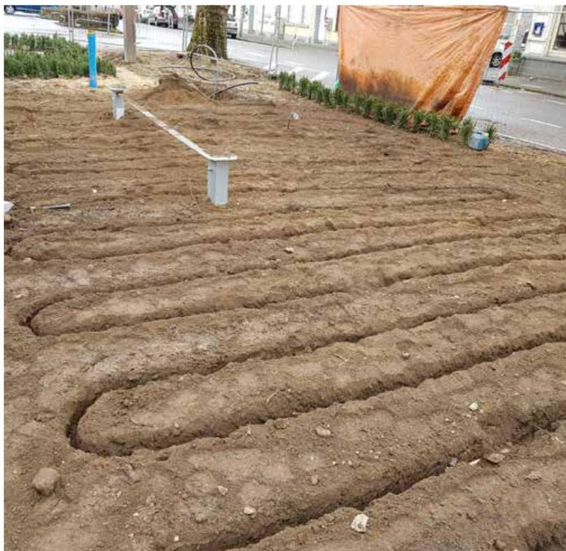
Gesteuert wird per Zeitschaltuhr: Magnetventile regeln die Wasserzufuhr zu den Versorgungsleitungen, die ebenso unterirdisch entlang der Wege gelegt wurden.
