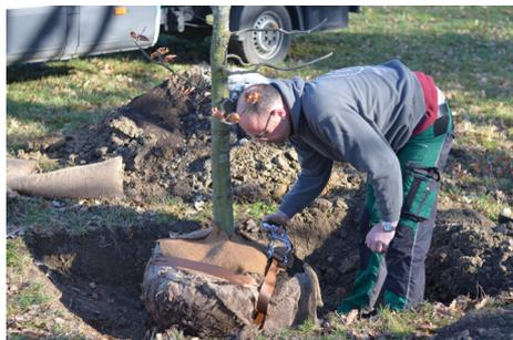
Um die Bäume an ihrem neuen Standort sicher zu verankern, hat Friedrichs GaLaBau auf unsere TREELOCK® Systeme zurückgegriffen. Um die Arbeiten zu beschleunigen wurde beim Einschlagen der Erdanker eine Motorramme eingesetzt, die Dank des SDS-HEX Aufsatzes mit unserer Einschlagstange kompatibel ist.
